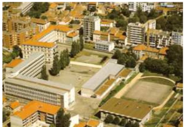
Vue aérienne du lycée et du collège (avant la rénovation)
